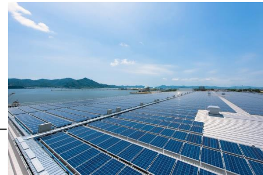
▲ 建物上部の太陽光発電設備
