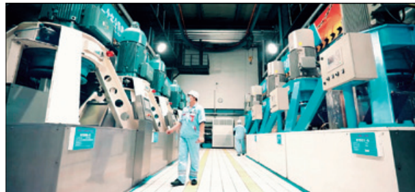
中糧糖業遼寧有限公司 新工場
